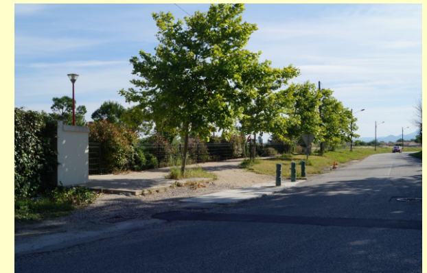
D: Cheminement piéton bordant le secteur 1Aua
