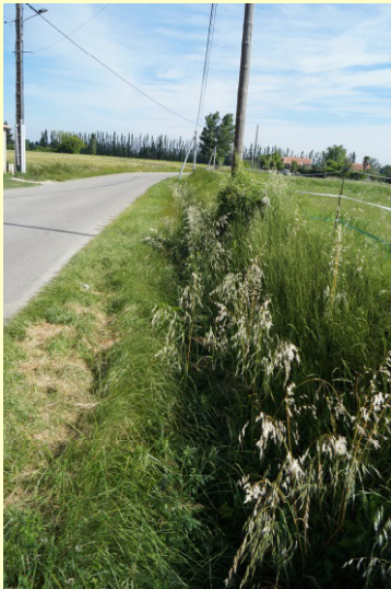
C: Fossé de collecte des eaux pluviales
